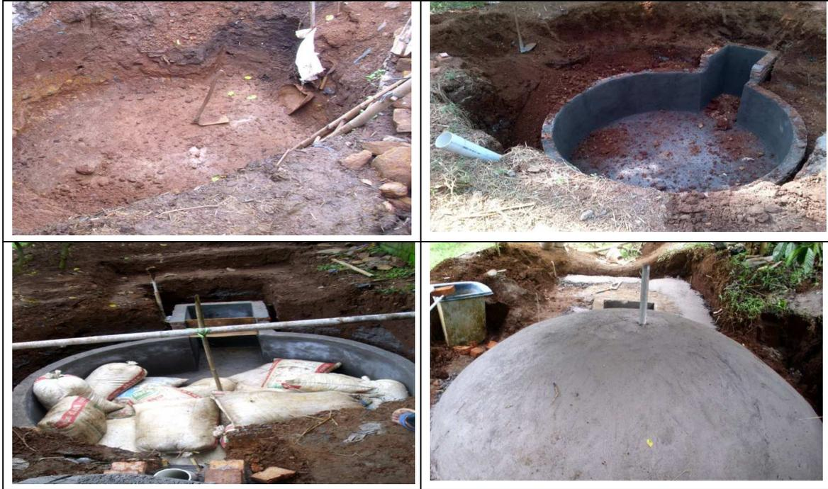
**Gambar 6. Pembuatan Instalasi Biogas di KTT Sumber Rejeki**
