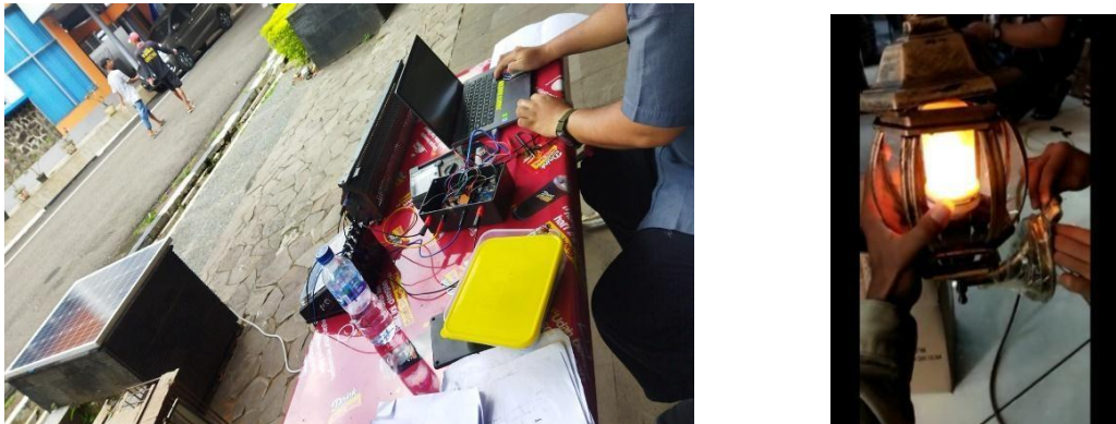
Gambar 9. Pemasangan lampu penerangan dan instalasi PLTS
